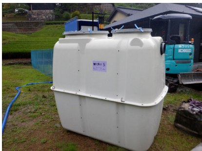
合併処理浄化槽
