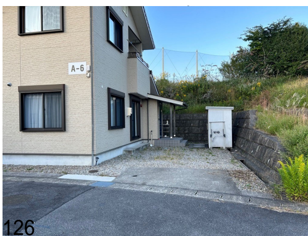
大西住宅公共下水道接続工事
