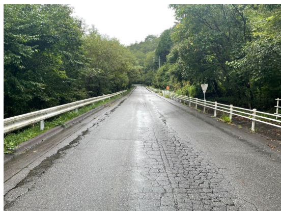
舗装修繕工事計画箇所 広域農道奥三河 2 期線 (沖駒区)
