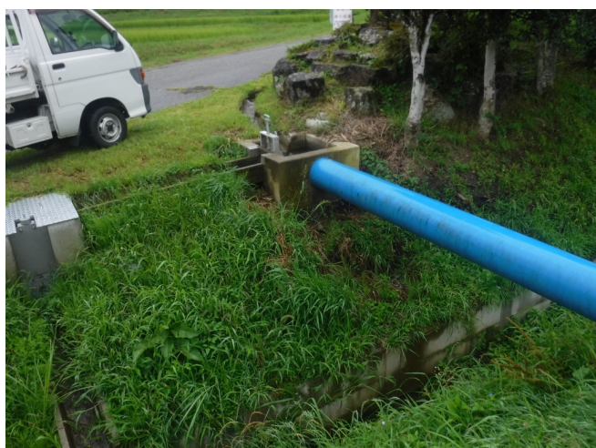
農地環境整備事業 柵修繕工事計画箇所（川口地区）
