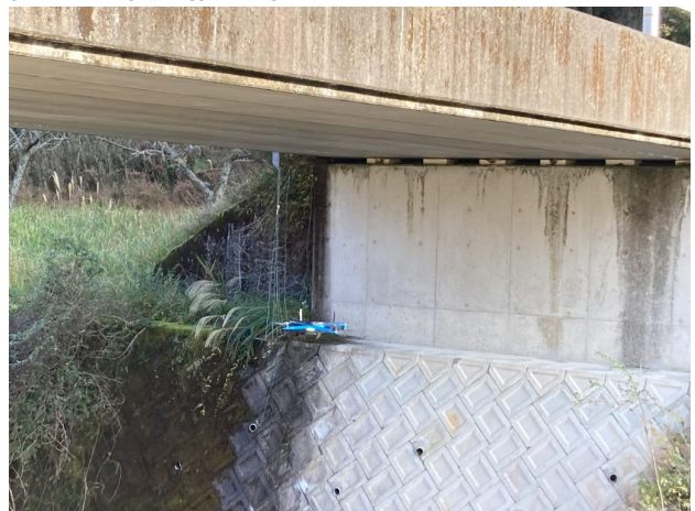
橋梁点検の状況（ドローン）
