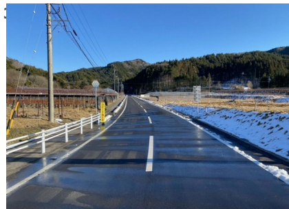
舗装打換え工事（町道名倉沖駒稻武線）
