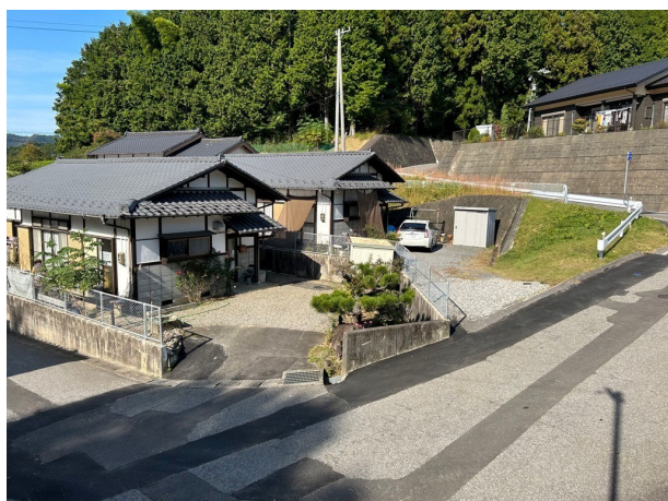
アラコ住宅公共下水道接続工事
