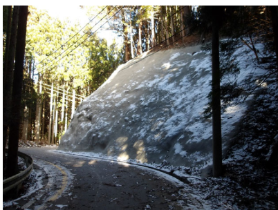
法面吹付工事（町道和市長江線）
