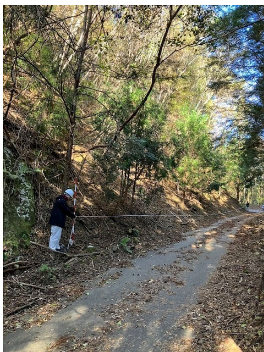
林道大沢中俣線 法面吹付計画箇所
