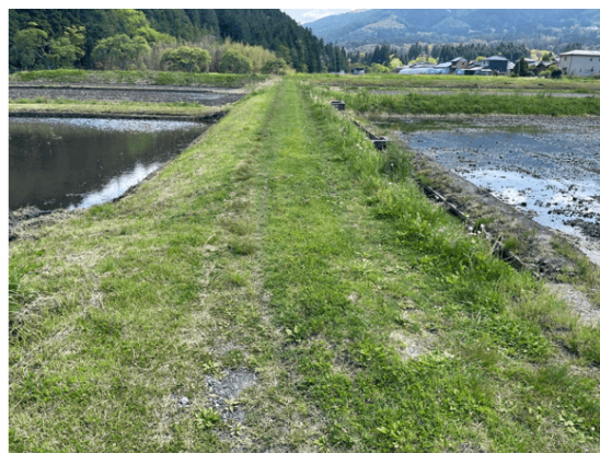
舗装新設工事計画箇所 (湯谷区)
