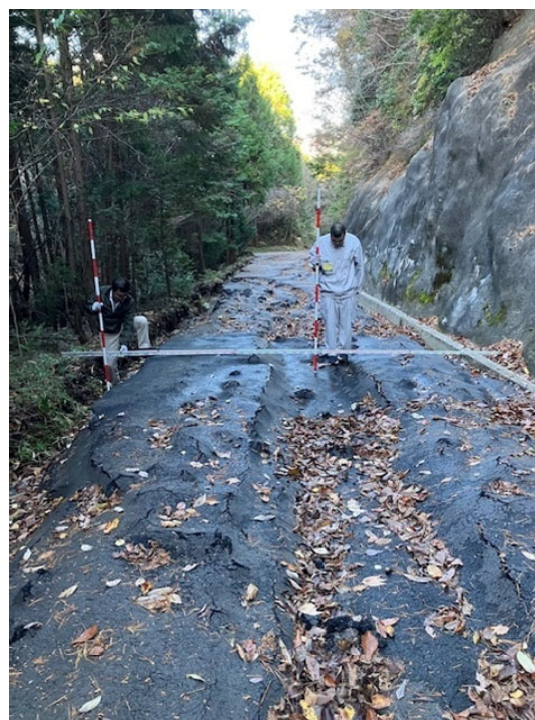
林道段戸 208-1 号線 舗装打替計画箇所
