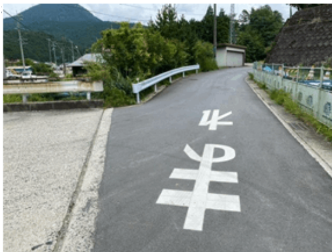
ガードレールの設置
