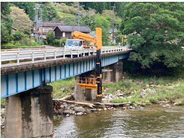
橋梁点検の状況（点検車）
